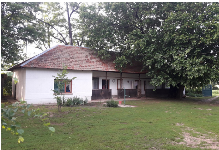
Kétsopronyi tanya felújítás után
